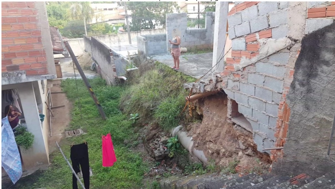
Figura 1 – muro de divisa - foto de 21/03/2018
